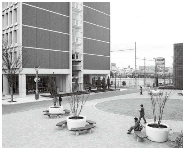
完成した芝生広場
